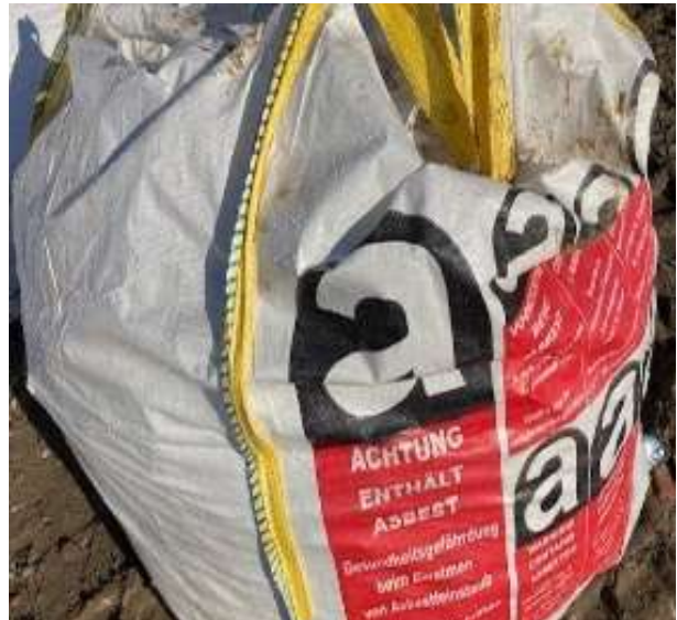
Big Bag zur Entsorgung von Asbest
