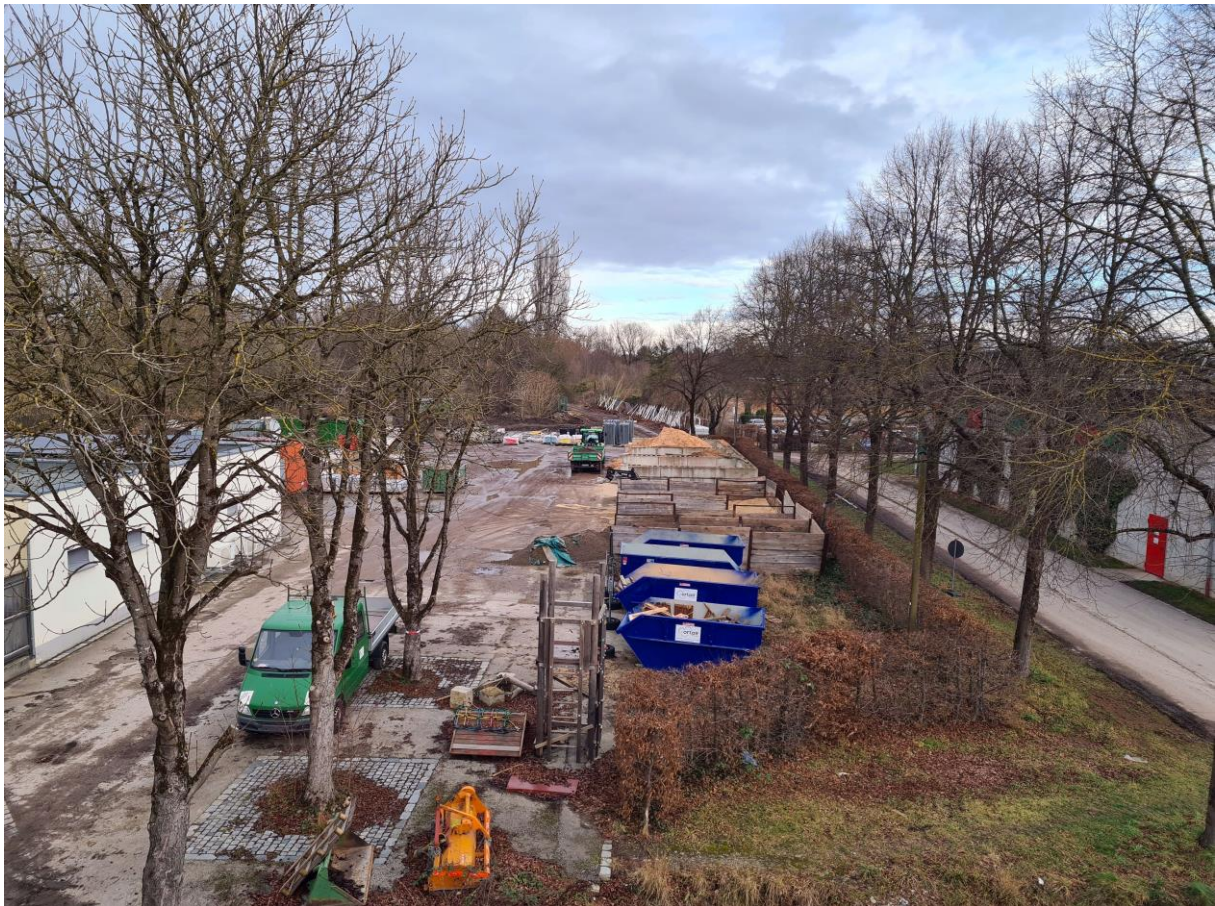
Blick vom Dach der neuen Werkstatt auf das Materiallager des AGNF mit Abfalltrennung, für das neue Umweltbildungszentrum wurden aussortierte Materialien recycelt und im Außengelände wieder verbaut, Bild: Anette Vedder
