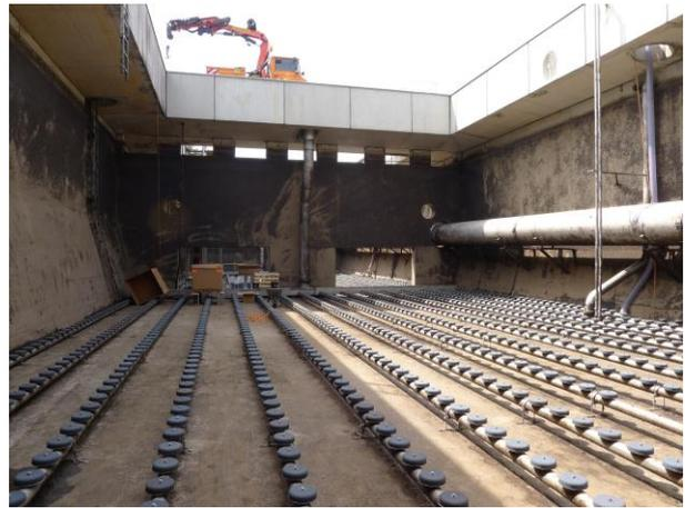
*Austausch der Belüfterdome in den Belebungsbecken; Ziel ist die Energieeinsparung durch eine bessere Luftverteilung in den Belebungsbecken (Bild: Stadtentwässerung Augsburg).*
