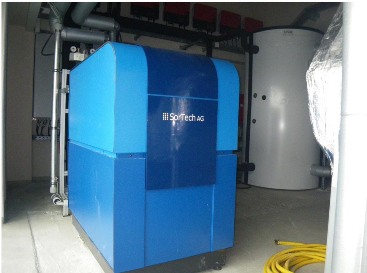
*Im Klärwerk sind ca. 20 Kompressionskälteanlagen in Betrieb, die relativ viel elektrische Energie benötigen. Durch den Einsatz der innovativen Technik einer Absorptionskälteanlage können ca. 2/3 der elektrischen Energie eingespart werden. Bei dieser Technik wird die vorhandene Überschusswärme aus der BHKW-Anlage mit Hilfe eines Sorptionsmittels zur Kälteerzeugung verwendet. Bild: Günter Wagner*
