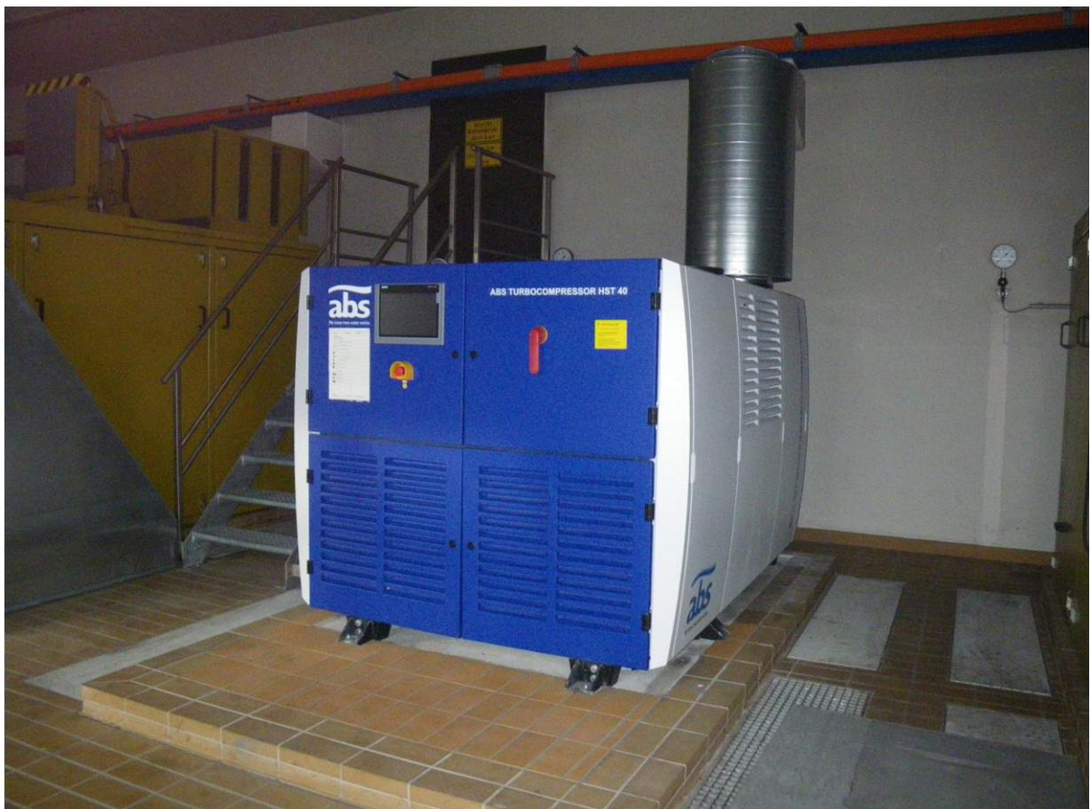
*ABS Turbokompressor (Turboverdichter): Für den Lufteintrag in die Belebungsbecken betreibt das Klärwerk eine Gebläse-Station mit insgesamt acht Turbogebbläsen. Der Einsatz von zwei neuen Turbo-gebläsen mit Magnetlagerung reduziert nun den Strombedarf erheblich. Bild: Günter Wagner*
